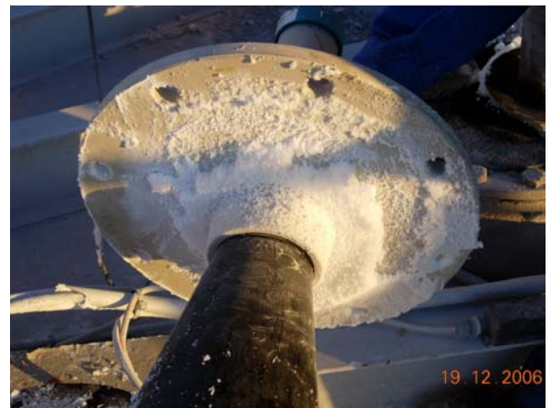
Fosforihappohöyryt kiteytyvät sekä mittauysyhteeseen että anturin pintoihin.
