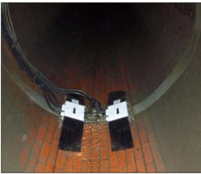
UniMag NFP -anturi sietää likaa ja pinttyymiä
