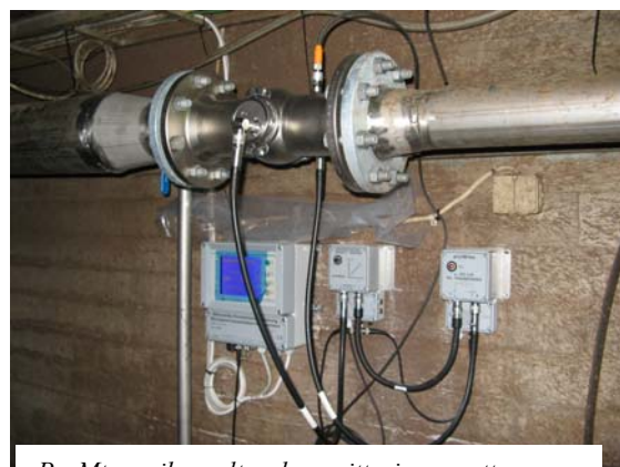
ProMtec-mikroaaltoakeusmittari asennettuna lietteensiirtoputkistoon paperitehtaalla.
