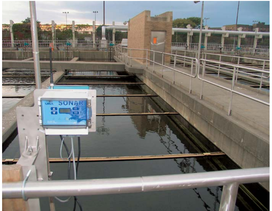
Jälkiselkeytyksaltaita varustettuna pintalietekaavaimella
