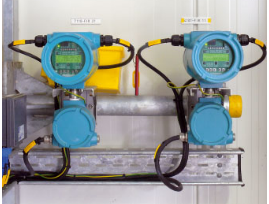
Asennuskuvaa, Ex-luokitettuja mittauslähettimeä (Fluxus®)
