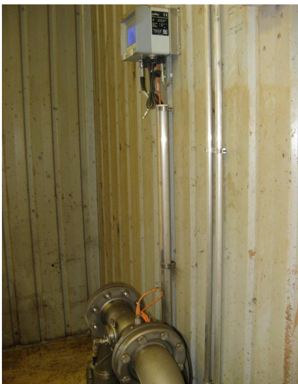
Kuva yllä: Lietelingolle menevän tiivistetyn lietteen kokonaiskuiva-ainemittaus (TS) toteutettuna μ-ICC 2.45 Compact -järjestelmällä
